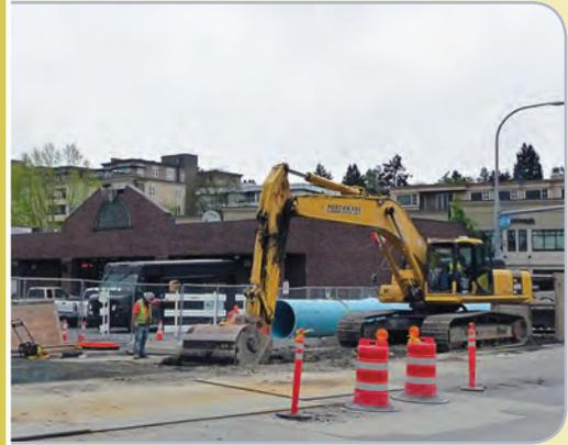
Instalación de tubería de drenaje a cielo abierto como parte de la mejora del drenaje local.
